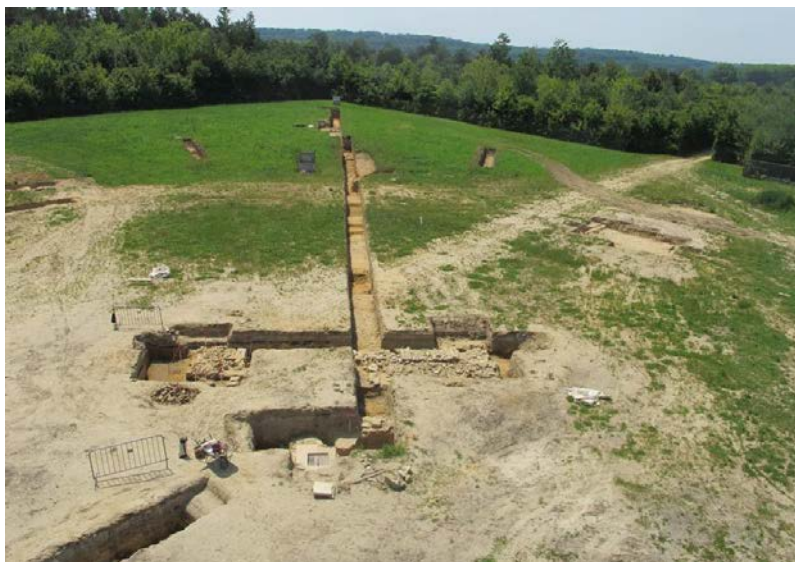
Vue du chantier prise à la nacelle, vers le sud © Annick Heitzmann (Château de Versailles), juin 2006
